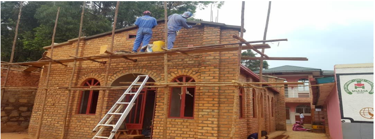
Chiesa in costruzione
