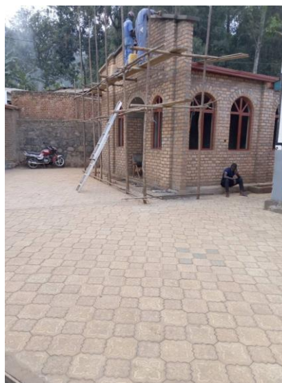
La chiesa in costruzione
